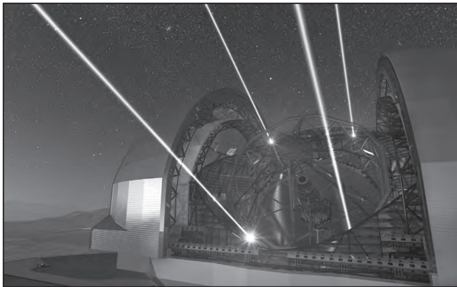
Obrázek 11: Umělecká představa použití systému čtyř laserů pro systém adaptivní optiky u plánovaného dalekohledu E-ELT ESO. Poděkování: ESO
