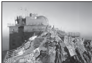
Obrázek 5: Observatórium na Lomnickom štíte (2634 m n.m.). Neutrónový monitor kozmického žiarenia je v kontajneri v popredí. Za ním je kupola korónálnej stanice. Foto: J. Rybák.
